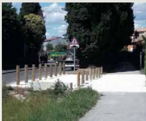
CD 34A : pose de bornes en bois pour la mise en conformité du passage pour les personnes à mobilité réduite
