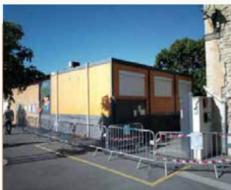
Mise en place d'équipements en raison des mesures barrières pour cause de COVID
