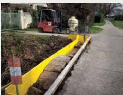
Réparation des ponts au chemin des Chutes pour une mise en sécurité des riverains
