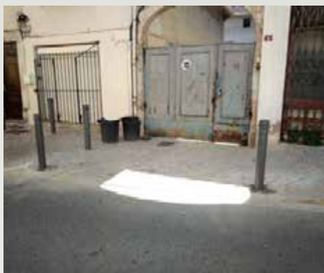
Pose de bornes Avenue Frédéric Mistral afin de délimiter l'espace trottoir et stationnement
