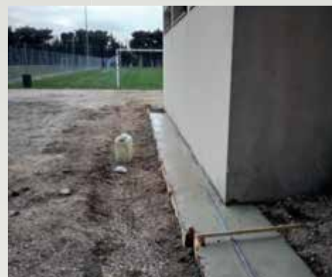
Stade : pose d'un portail coulissant afin de sécuriser les installations
