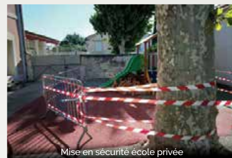
Mise en sécurité école privée
