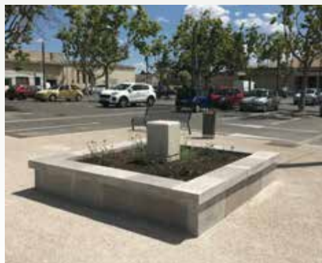
Repositionnement de l'ancienne fontaine reconvertie en jardinière fleurie sur la Place du Marché face à la pharmacie (en cours d'achèvement)
