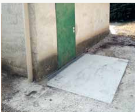
Tennis : création d'une dalle, écoulement et pose de gouttières sur le bâtiment des toilettes à l'arrière du bâtiment
